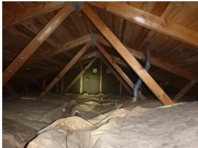
Bilden visar vy av vind.
