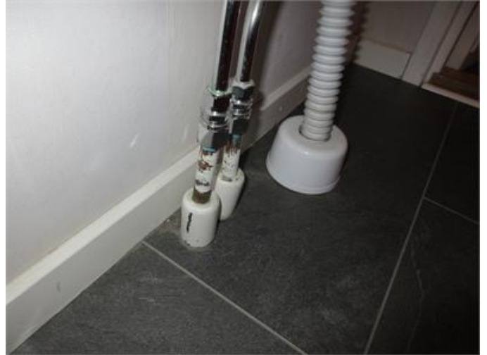
Rör genomföring i toalettutrymme
