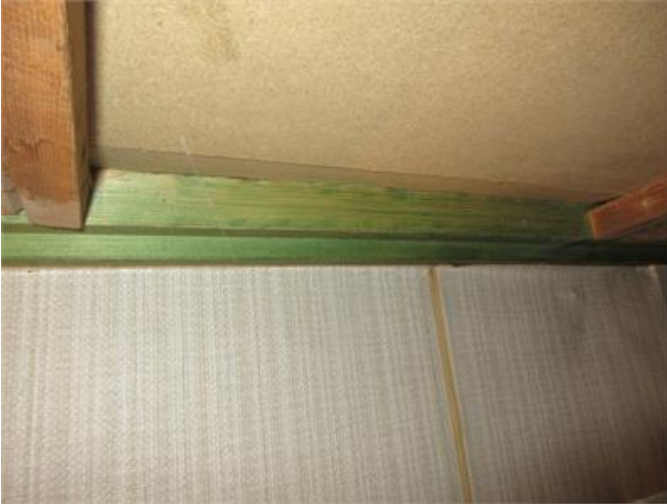
Tryckimpregnerad syll i krypgrunden
