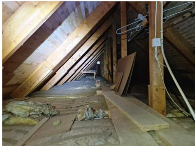
Vy på vindsutrymmet (ovan huvudbyggnad)
