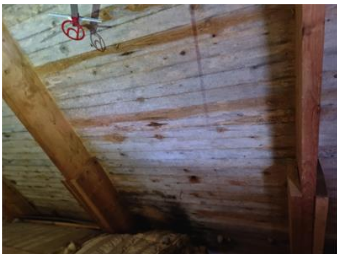
Vy på vindsutrymmet (ovan huvudbyggnad)
