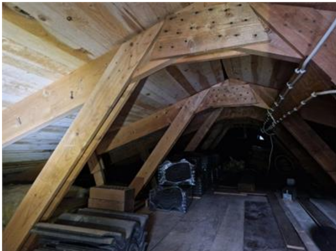
Vy på vindsutrymmet (ovan garagebyggnad)
