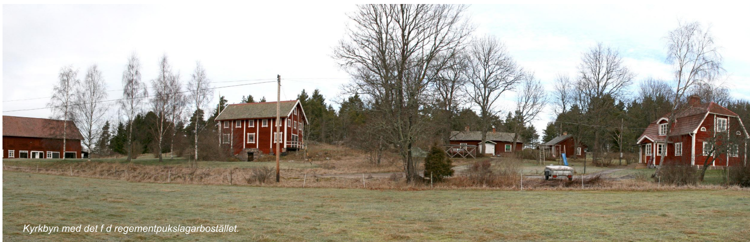
Gottröra kyrka i centrum med äldre gårdar och yngre bebyggelse utmed landsvägen. Intill kyrkan ligger äldre skolbyggnader. Öster om kyrkan uppfördes ett ålderdomshem (se nästa sida).
