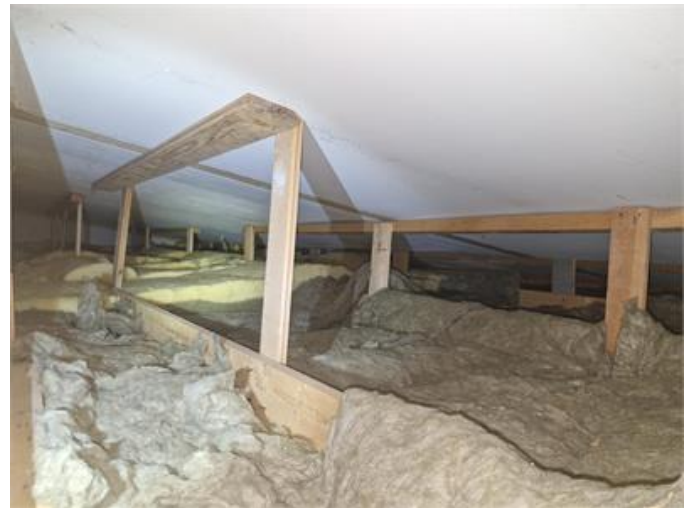
Vindsutrymme ovan Vardagsrum, översiktsbild.
