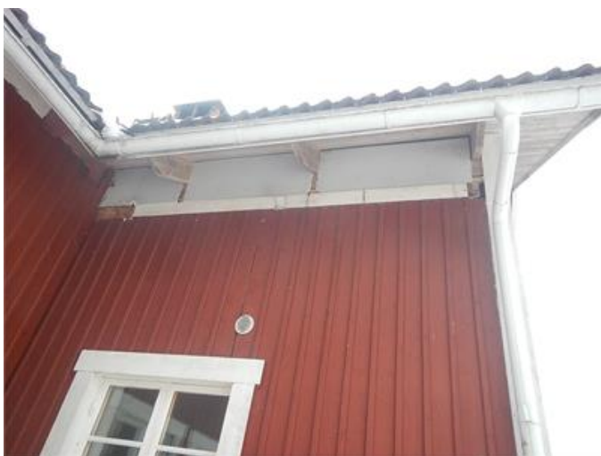
Fasaddel som består av gipsskiva.
