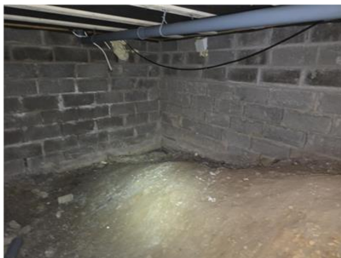
En del av krypgrunden.
