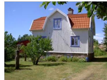
Lyse-Berga 3:18 BA:40, TA:655, BR:110+bef.uthus Byggår 1904, k, dubbelhus Vit träpanel, tegeltak, stengrund Välbevarad exteriör
