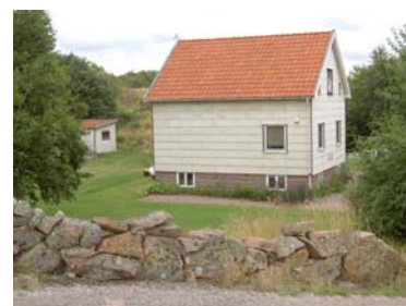
Lyse-Berga 3:39 BA:55, TA:2270, BR:200 Byggår 1941, dubbelhus Vit eternit, tegeltak, stengrund
