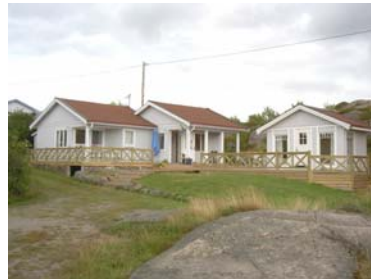
Lyse-Berga 2:124 BA:55, TA:860, BR:200 Byggår ? Ljusgrå träpanel, tegeltak
