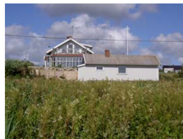
Lyse-Berga 3:4 BA:80, TA:1045, BR:200 Byggår 1905, k, dubbelhus Ljusgrå träfasad, tegeltak
