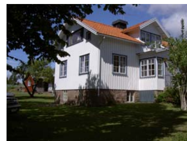
Lyse-Berga 3:3 BA:65, TA:1180, BR:135+bef.uthus Byggår 1898, k, dubbelhus Vit träpanel, tegeltak, stengrund
