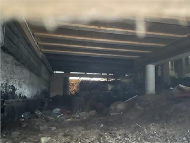
Plintgrund under entréhall.
