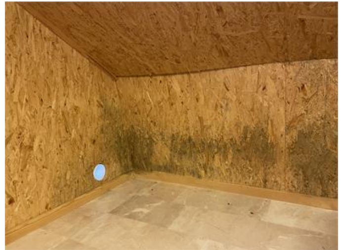
Missfärgning noteras i vind 1.
