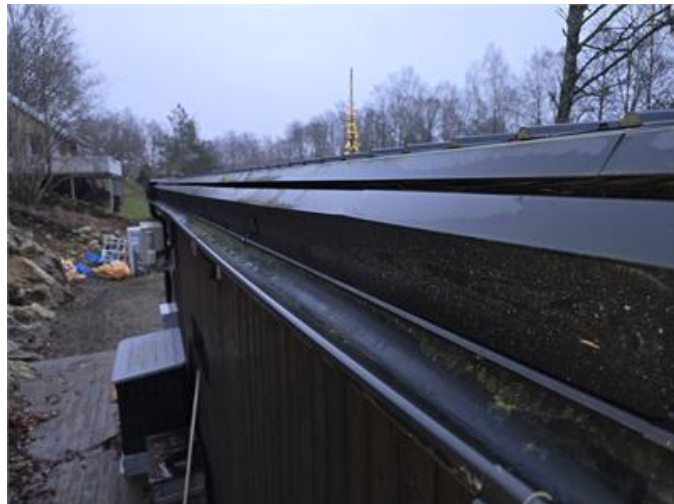
Bilden visar hänggräna som är lågt placerad.
