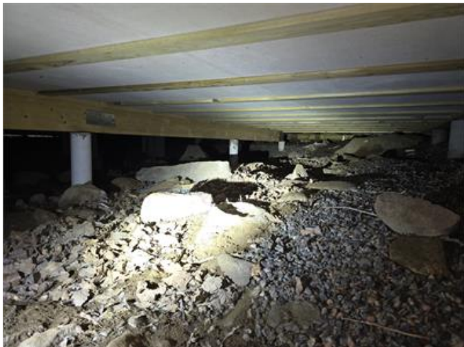
Bilden visar en överblick i del av plintgrunden.
