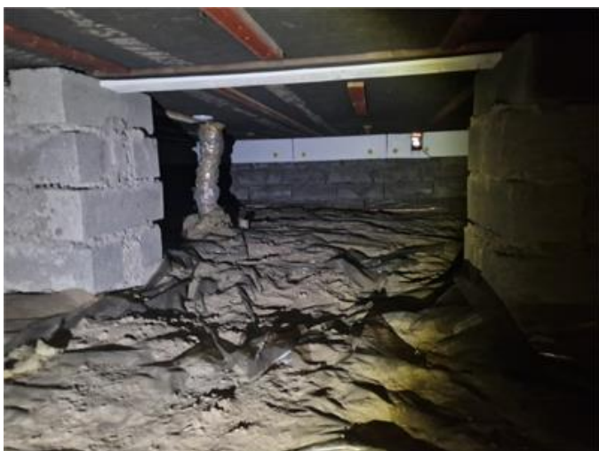
Vy i krypgrund
