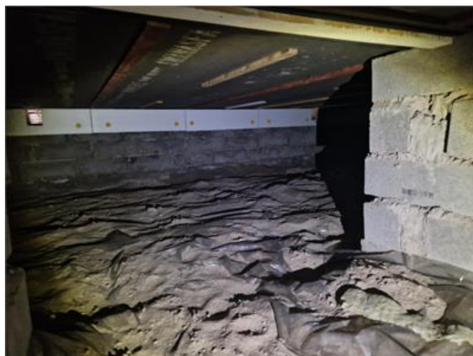
Vy i krypgrund
