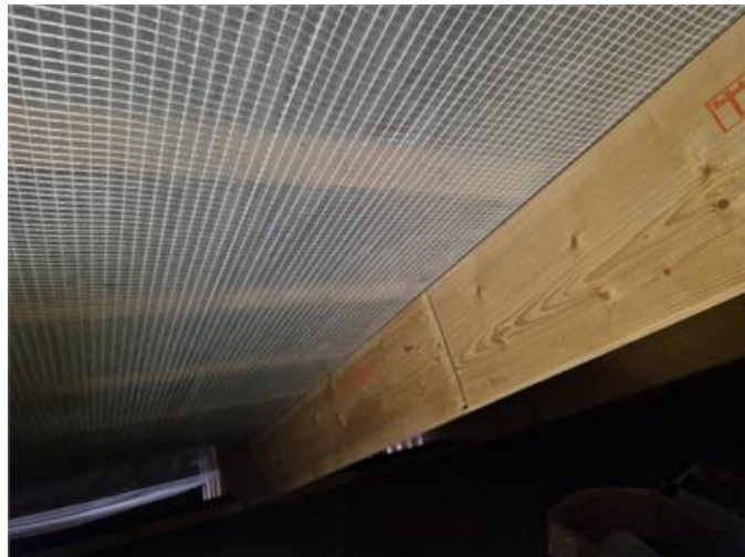
Vy på underlagstak
