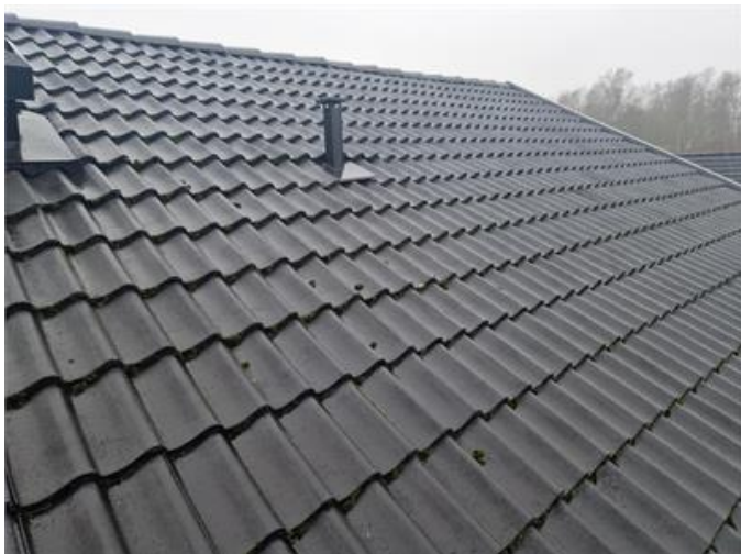
Vy på yttertak
