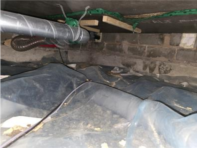
Översiktsbild krypgrund under dusch/wc.
