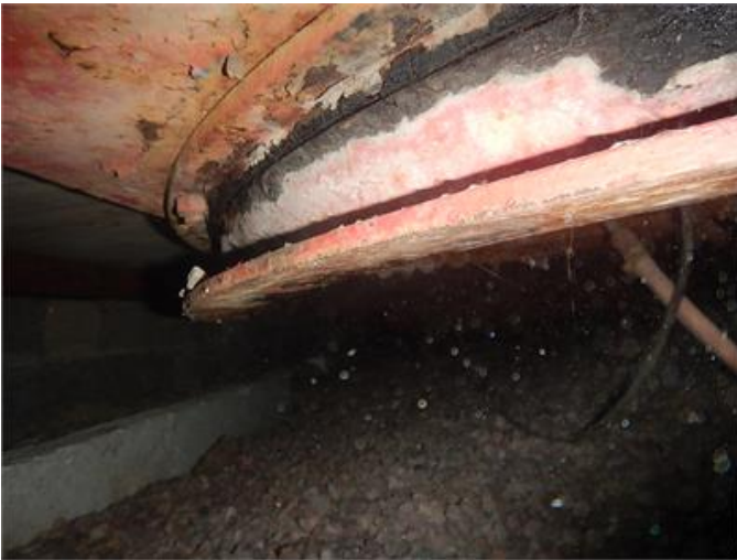
Vy över del under byggbarack.
