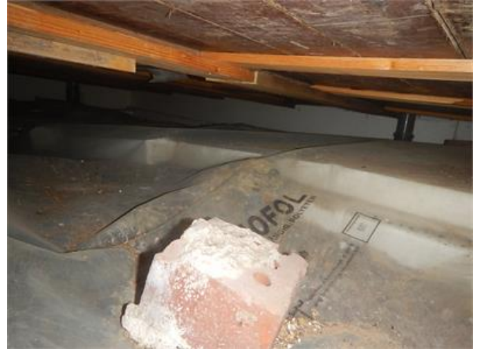
Vy över grund under dusch/wc via ventil.
