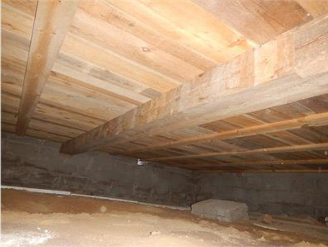
Vy över krypgrund.
