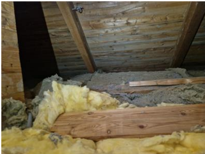
Vy på underlagstak
