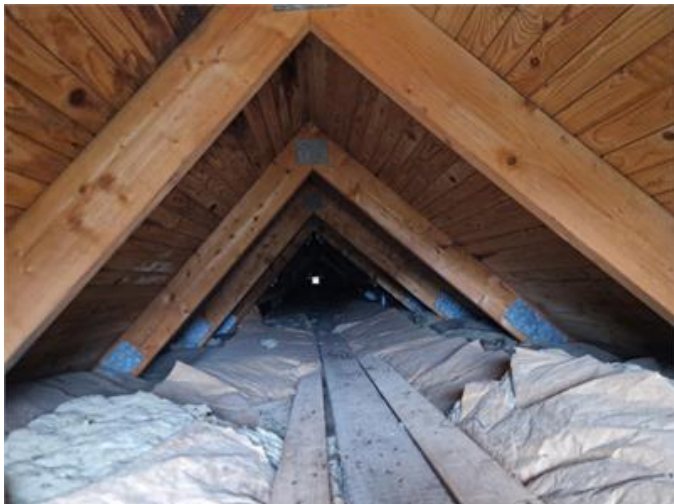
Vy på vindsutrymmet
