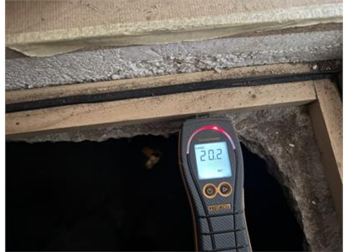
Fuktkvotsmätning i träram till krypgrund.
