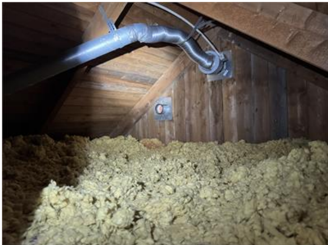
Ventilationskanal oisolerad.
