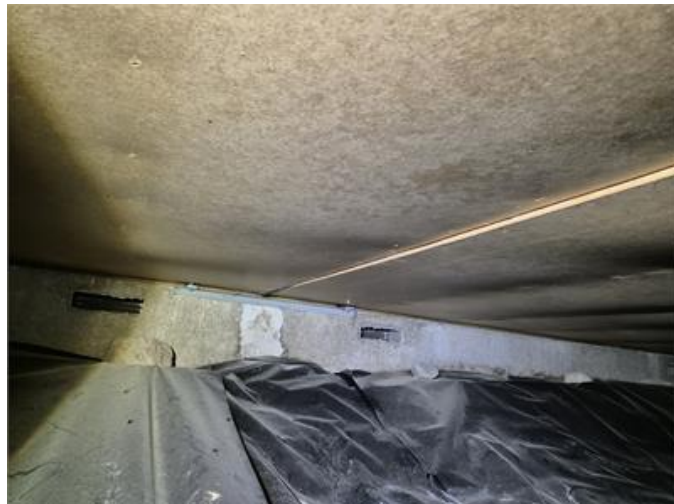
Bild från krypgrunden.
