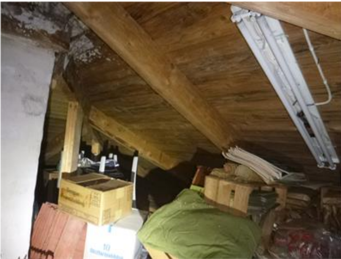
Bilden visar vy av vind.
