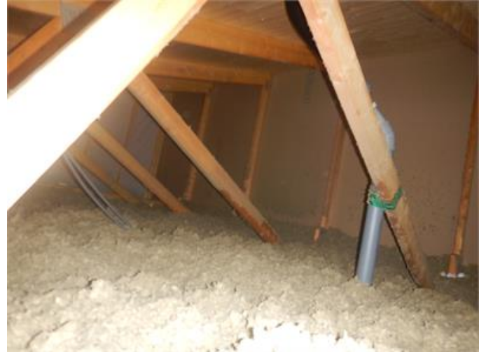
Vy över vind carport.
