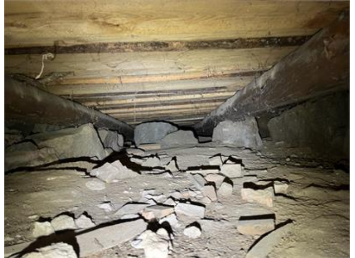
Bild från krypgrunden.
