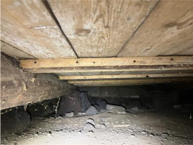
Bild från krypgrunden.
