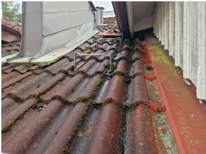
Vy på yttertak
