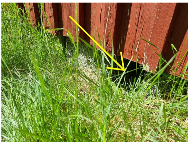
Bilder tagna genom ventil enligt pil, ingen lucka till grunden noteras vid besiktningstillfället.
