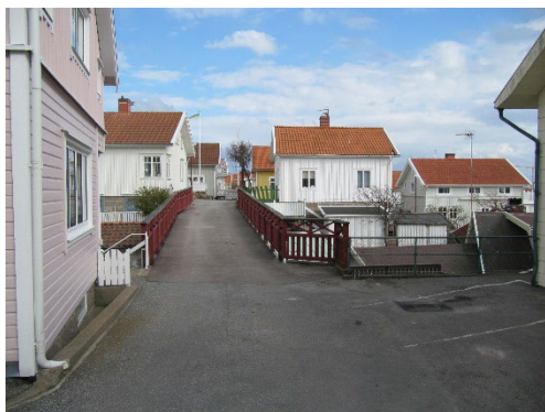
Bro vid Evert Taubes väg
