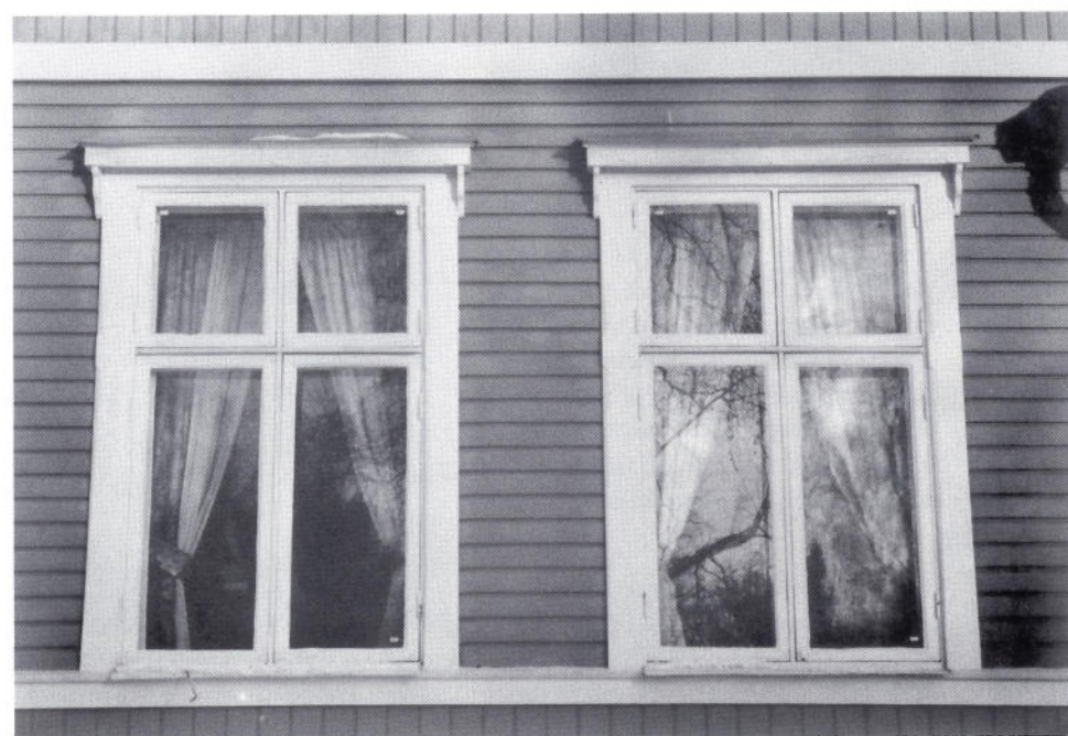
Fönstrens proportionering och gruppering är av stor betydelse för fasadens utseende. (kv Lövsången 1, Sveavägen)
