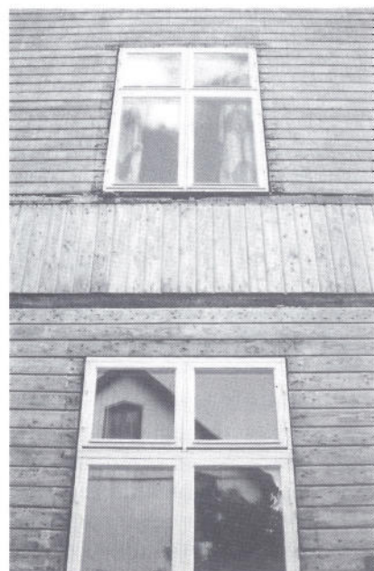
Den här i stort sett intakta panelen hittades under eternit och puts. (kv Grönsiskan 4, Oskarsvägen 11)
