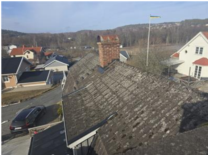
Översiktsbild, äldre yttertak.
