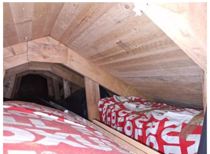
Nockvind, översiktsbild norra delen från luckan.
