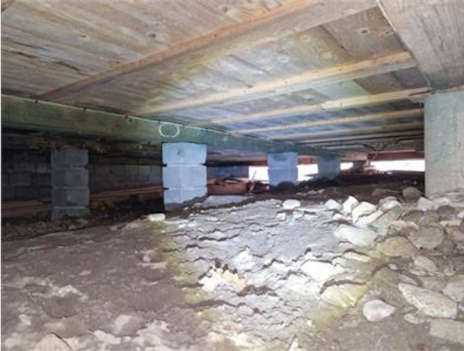
Plintgrund, översiktsbild ursprunglig del.
