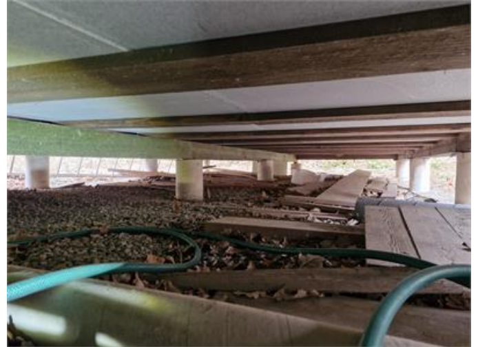
Plintgrund, översiktsbild utbyggnad norr.
