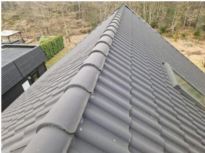
Vy på yttertak
