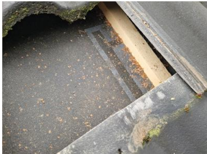
Vy på underlagstak
