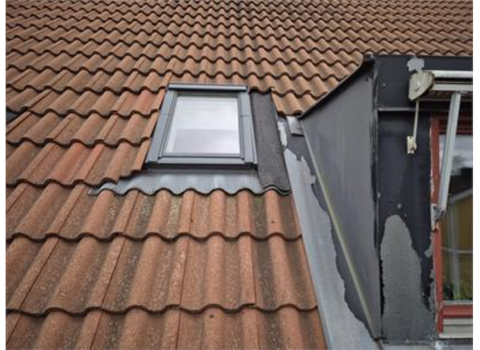
Mellan takfönster och homeja på framsidan av huset har täckbit av tjärpapp monterats.
