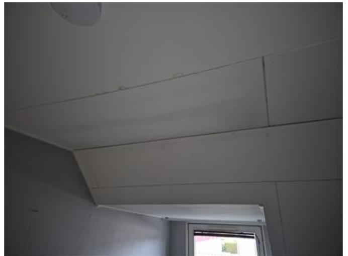
Fuktfläck/skada i tak beror enligt fastighetsägare på tidigare och åtgärdat läckage. Ingen förhöjd fukt kunde indikeras.
