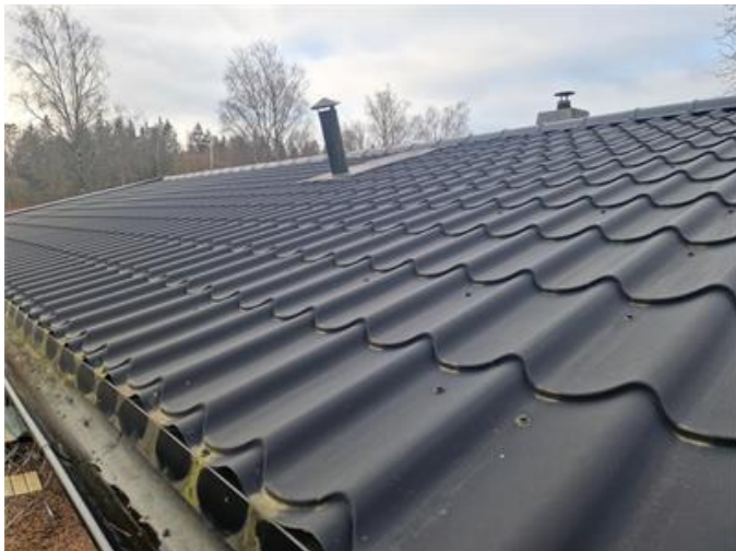
Vy på yttertak
