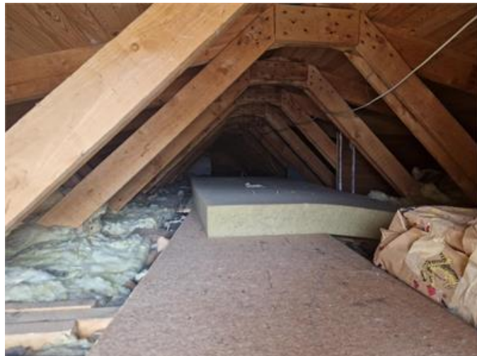
Vy på vindsutrymmet
