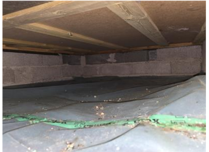
Krypgrund: Översiktsbild mot norr.
