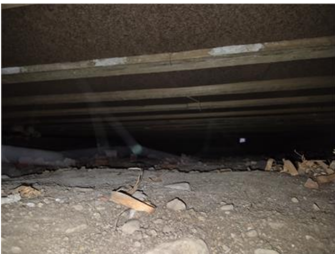
Bild från krypgrund som endast i mindre omfattning kunde besiktigas.
