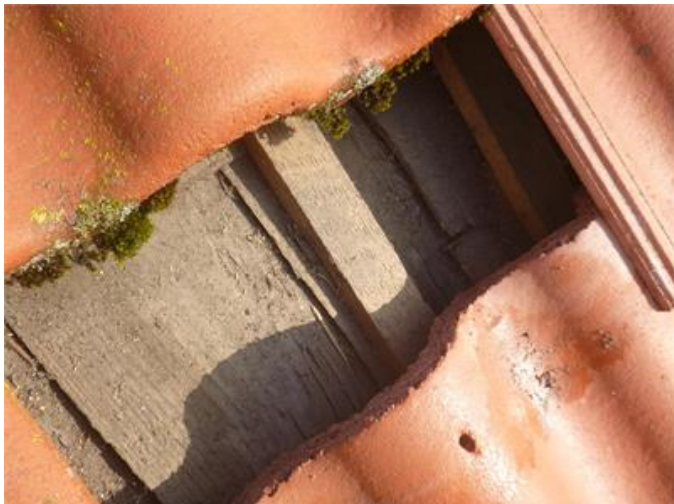
Bilden visar del av underlagstaket som består av sticketak.
