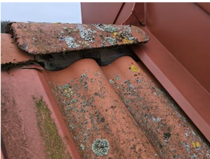
Tak: Otätheter vidnock utan nocktätning.
