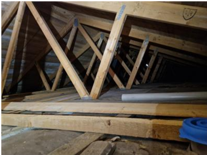
Vy på vindsutrymmet
