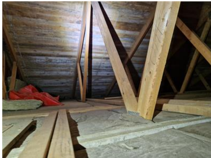
Vy på underlagstak med mikrobiell påväxt
