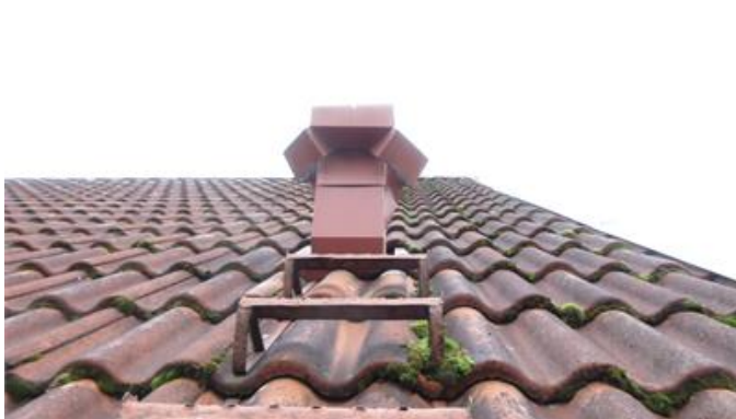
Trasig/tilltryckt plåthuv på tak.
