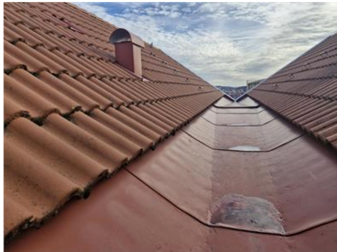
Tak, låglutande rännal mellan huskropparna.
