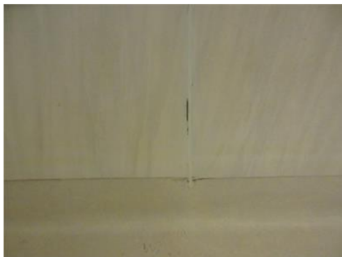
Glipa i våtrumsmatta på duschvägg
