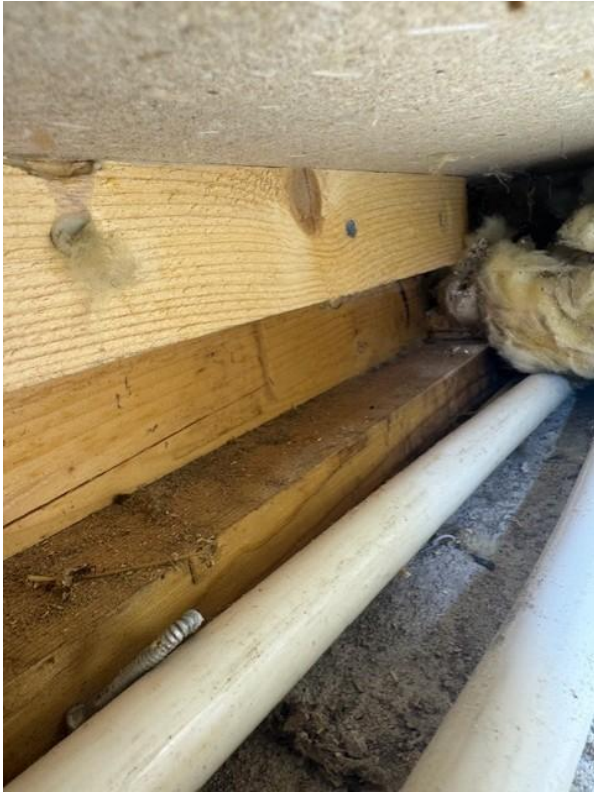
Bilden visar träskyddsbehandlad ytterväggssyll.
