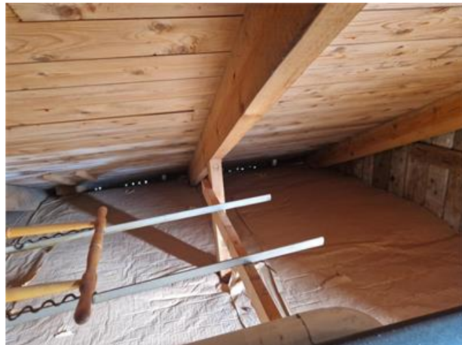
Vy på underlagstak
