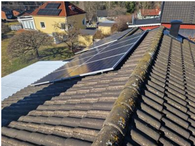
Vy på yttertak
