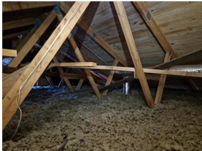
Vy på underlagstak
