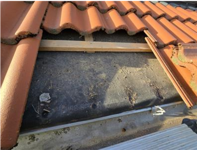
Pannor ligger på underlagsduk utan takfotsplåt.
