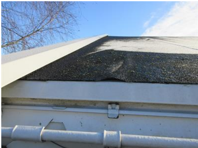
Exempel på takpapp som släpper
