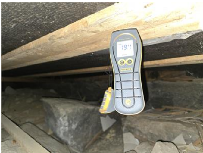
Exempel på fuktmätning via en ventil till torpargrunden.
