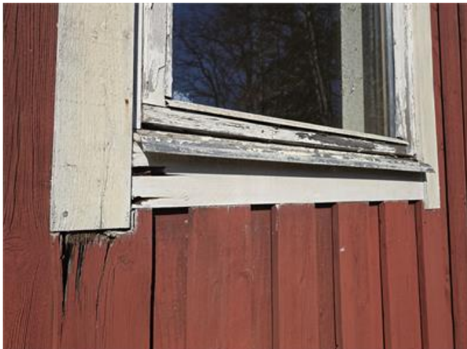
Exempel på panel och fönster.
