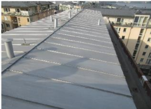
Del av yttertaket i falsad plåt
