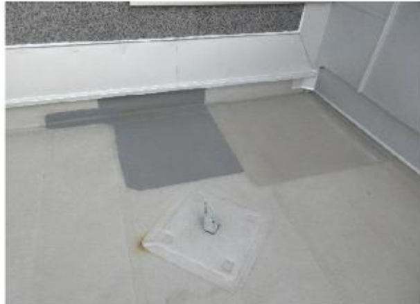
Tätskiktsduk på de plana delarna av taken
