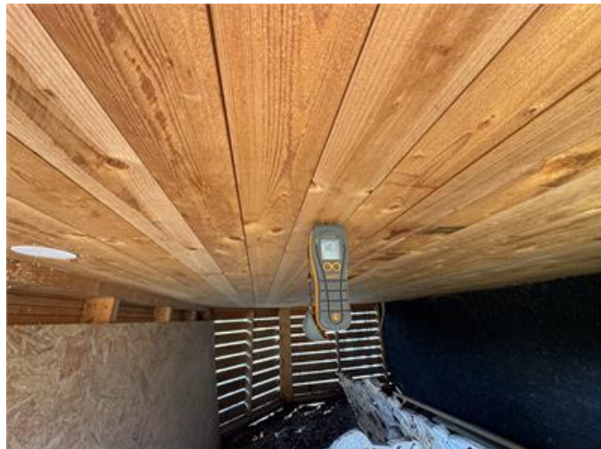
Fuktkvotsmätning i plintgrundens blindbottenbrädor.
