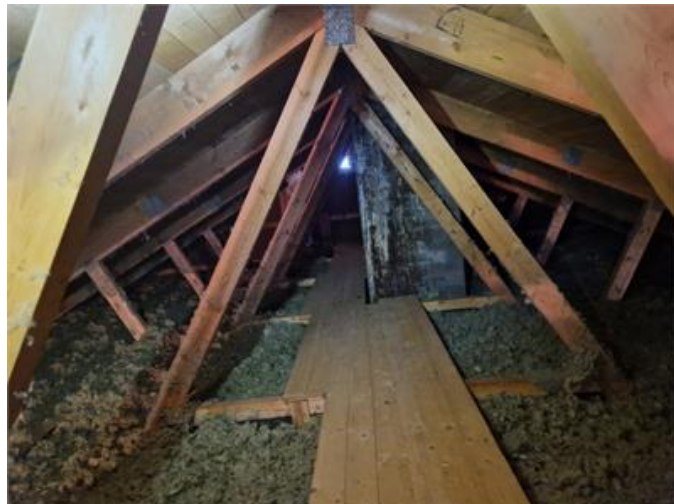
Vy på underlagstak
