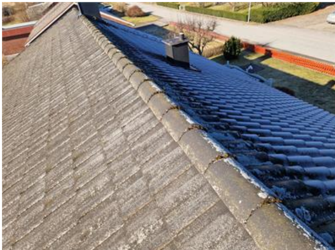
Vy på yttertak
