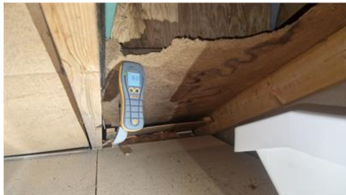
Bilden visar träfiberskivor med fuktfläckar på vinden ovan före detta garage
