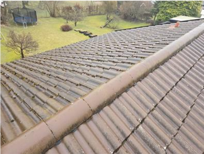
Överblick del av yttertak.
