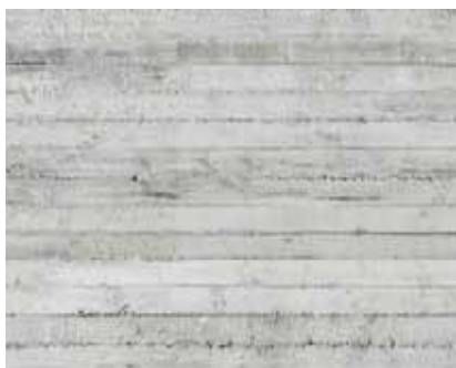
Omålad betong, gjuten mot brädform
