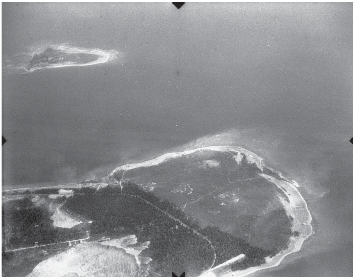
Flygfoto över Bungenäs 1943. Den södra udden har nyligen avverkats av försvaret för fri sikt mot havet i öster. Samtidigt bryter kalkbolalet sten i både väster och österklintsbrotten. I norr syns Bungeör.
