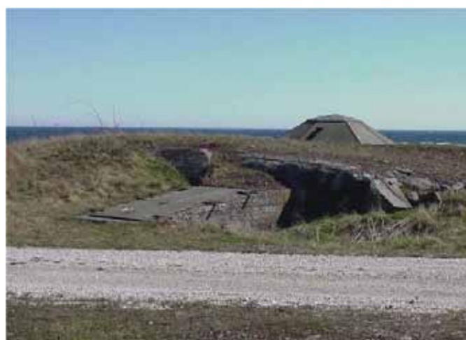
Befintlig byggnad nr. 62 straxt nedanför vägen.
