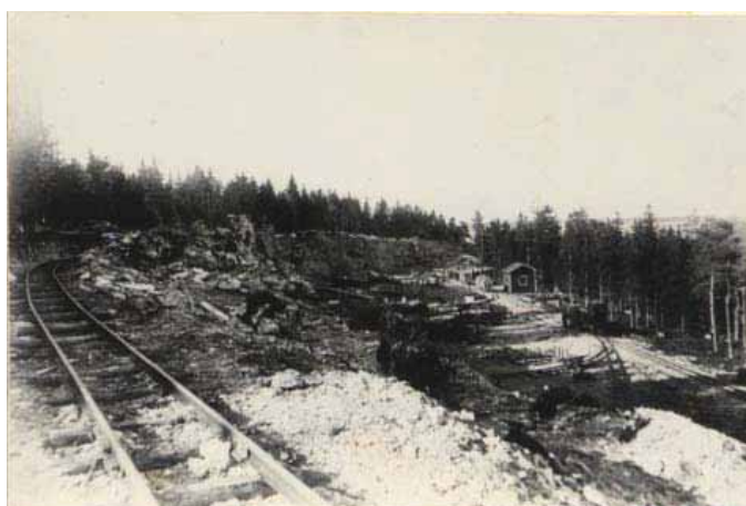
Till Österklintbrottet gick det järnväg under kalkindustritiden. Här fanns även ett antal byggnader bla. maskinhus och värmestuga.
