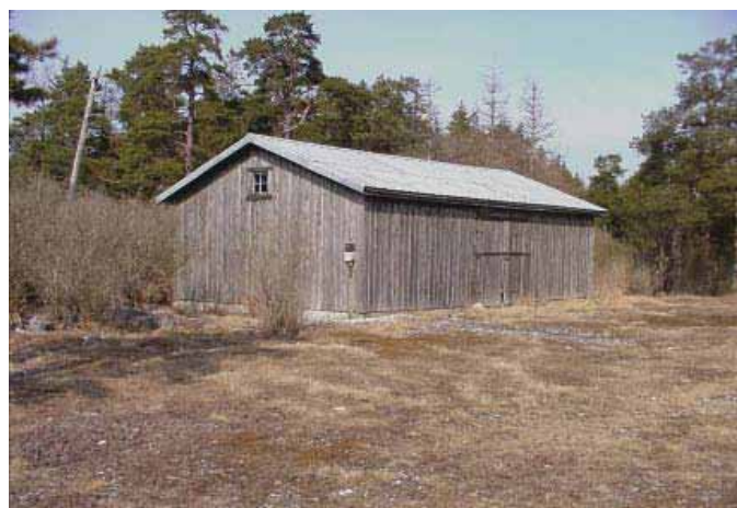
På Savannen riven byggnad nr 88, Fortifikationsverket Naturligt grånad virke som fasadmateriel. Enkel volym, nockhöjd ca 4m.
