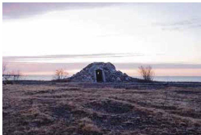
Befintlig bunker nr 22:31.
