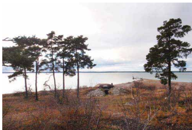
Befintlig värn 22:40. Platsen benämndes av försvarsmakten "Vargen". Från bunkern bevakade man hamnen och inloppet.
