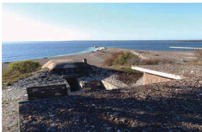
Befintligt värn 22:40, Fri havsutsikt över vägen. Bunkern ligger ca 12 meter över havssytan och 7 meter ovan vägen. Bild tagen 2011 från det grustäckta taket.
