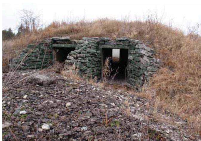
Befintlig ingång till bunker, kamoflagemålad kalksten.
