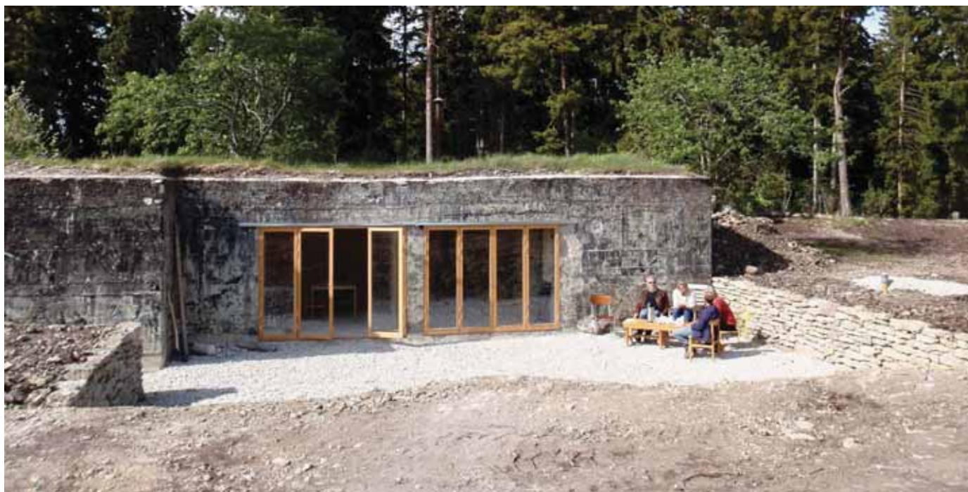
Byggnad nr 8, tidigare sk. "frontverkstad" ombyggd till kontor.
