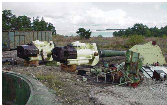
Nedmontering av pjäsvärn (byggnad 104).
