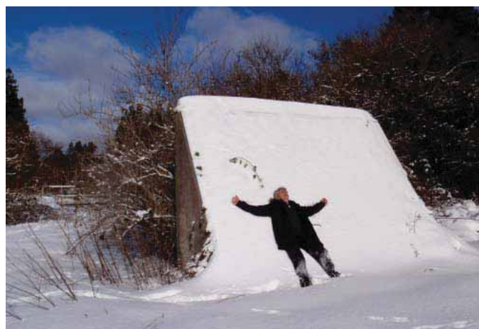
Platsfoto, Bungenäs hinderbanan. Betonghinder mot söder.
