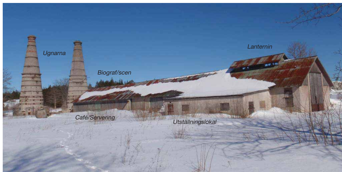
Kalkladan och ugnarna, uppförda ca 1910 i silikattegel. Ladnan hade tidigare spåntak vilket var det enda material som stod emot flygande stenskärvor från brottet.
