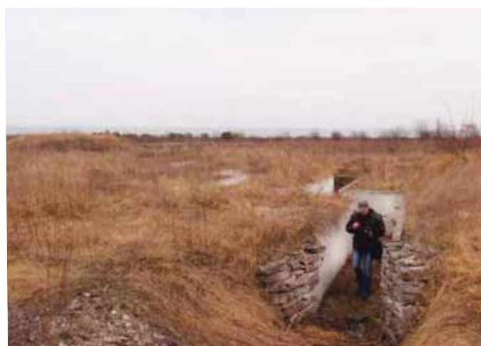
Nedgång i skyttevärn av betong.
