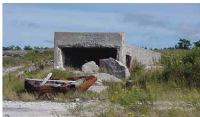
Änden på den 80 meter långa transporttunneln. I borte änden, i anslutning till vägen, ligger det högre krossverket.
