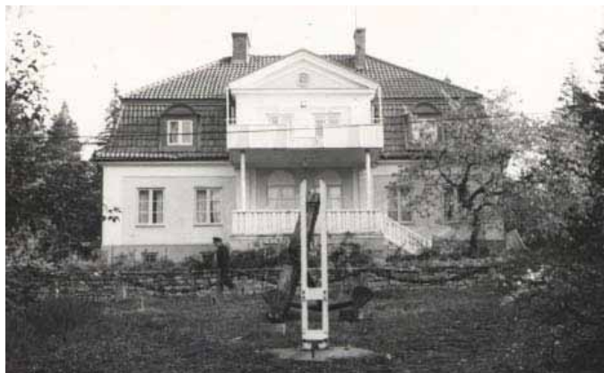
Förvaltarvillan med påbyggd balkong ca 1940-tal.
