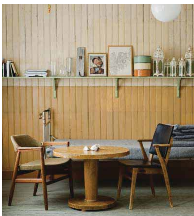
Del av den återställda interiören i butiksrummet, träpanelen färgerna är original och endast frilagda och rengjorda.
