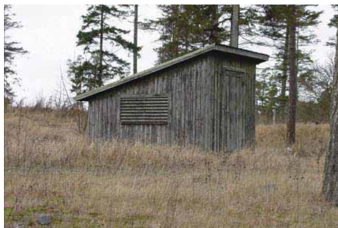
Foto, Fortifikationsverket. Den enkla träbyggnaden uppe vid barack David, 25 möh. dölde en nedgång till byggnad 101, 20m ner i berget.
