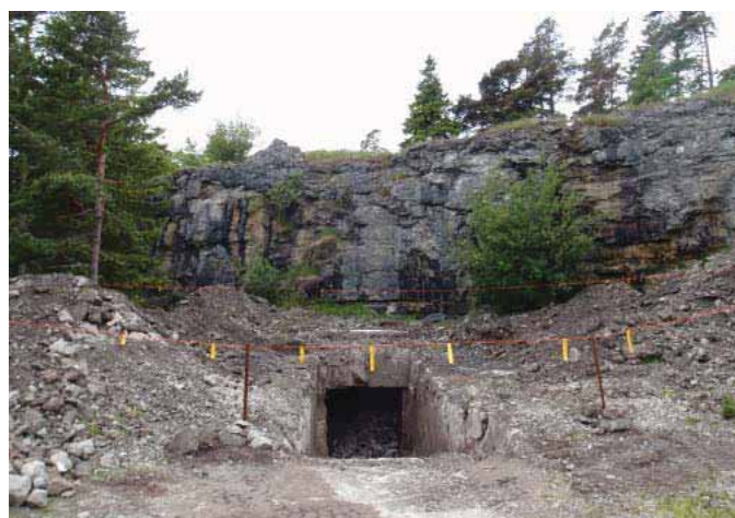
Nedgång till Kustspaningsradarstationen, byggnad nr 101.
