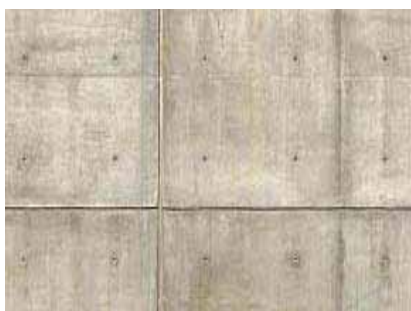
Omålad betong, gjuten mot skivform
