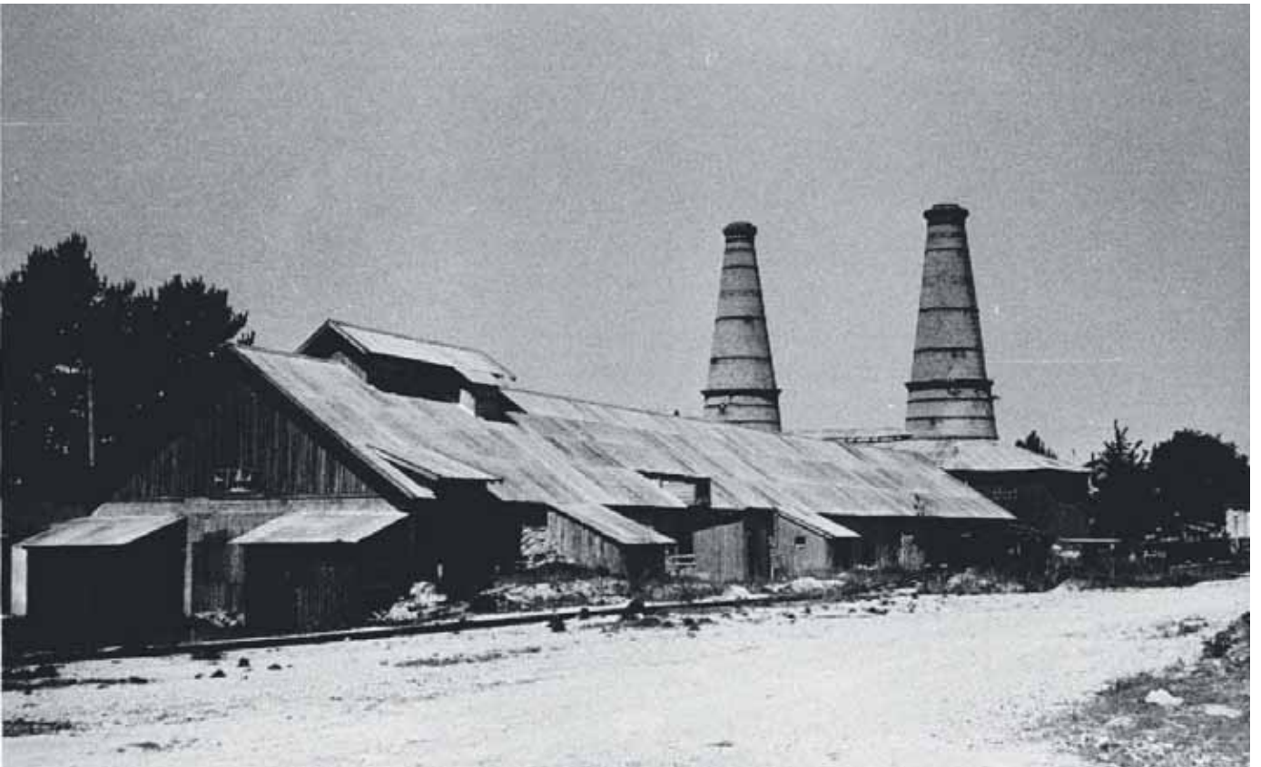
Kalkladan och de kringbyggda ugnarna.
