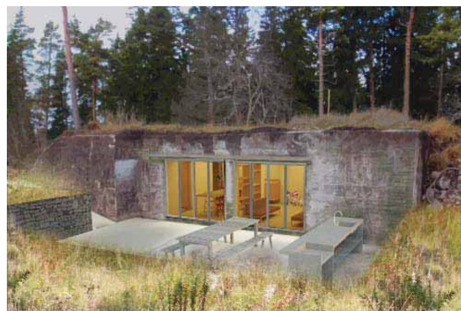
Visningshus, platskontor och information i befintlig bunker nr 8.
