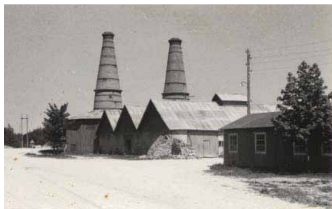
Ugnarna var kringbyggda med verkstäder, maskinhus och magasinbyggnader för lagring av den brända kalken.
