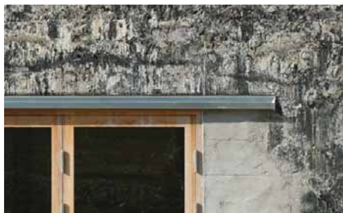
Befintligt möter nytt! Den framgrävda betongfasaden, bestruken med varmasfalt är uppsågad för lokalproducerade glaspartier i gotländsk oljad kärnfuru. Ränna ovan glasparti i zinkplåt.
