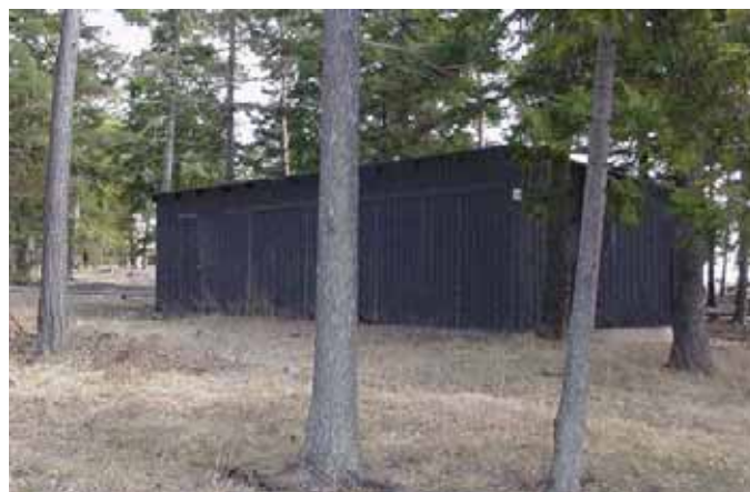
Exempel på träbyggnad uppförd av försvaret på Bungenäs.
