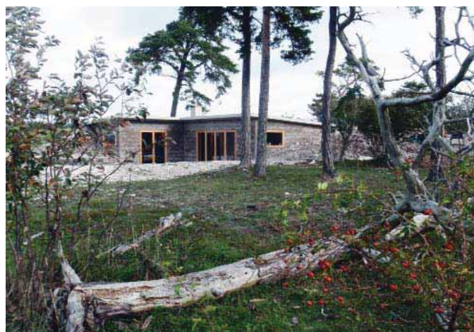
Nybyggnation under uppförande våren 2011.
