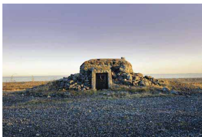
Bunker 22:37, en av många kvarvarande värn på södra udden. Bunkern är öppen och tillgänglig som allmänt besöksmål.
