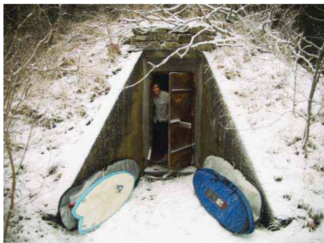
Ombyte i bunker nr 310 nedanför Saharaområdet. Byggnaden har använts som ammunitionsförråd men blir öppen året runt som offentlig värmestuga. Vedspis installeras samt ny glasad entrédörr innanför befintlig ståldörr.
