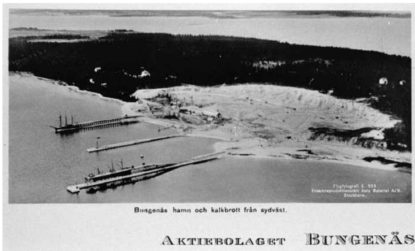
Bungenäs kalkbrott från Sydväst, 1929.
